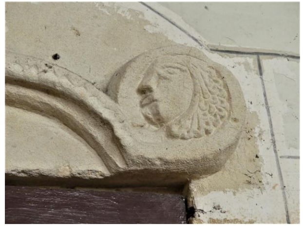
macaron du linteau de l'escalier des combles
